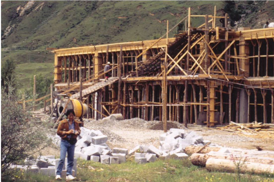
Palden Tawo vor dem Rohbau unserer Schule
