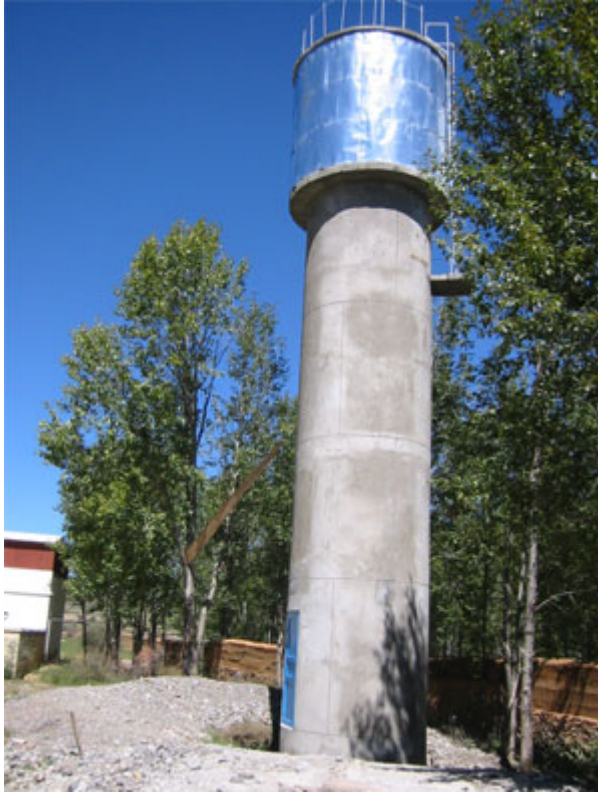
Der neue Wasserturm
