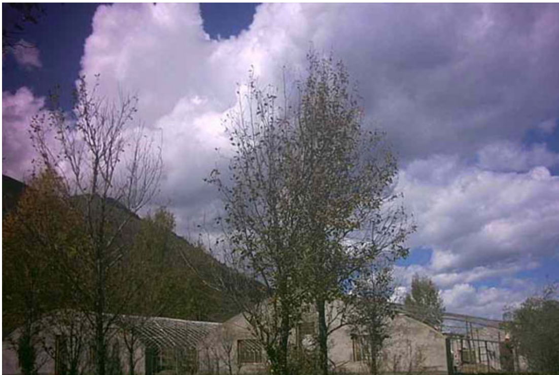
Die beiden Gewächshäuser im Bau
