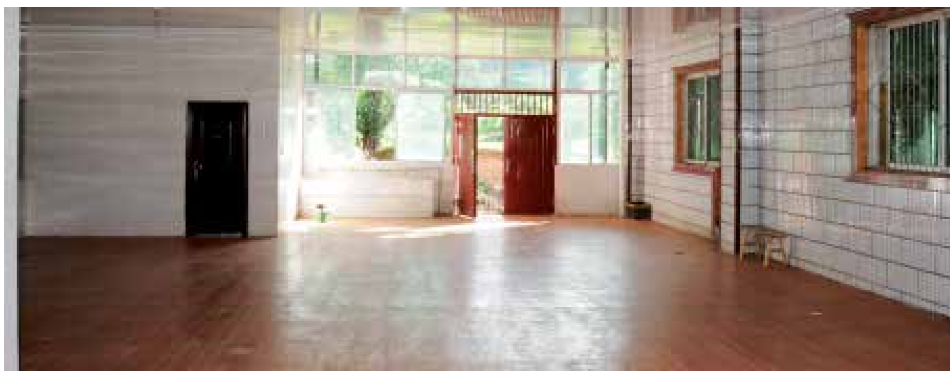
La pièce nouvellement créée entre les maisons, la cuisine et la salle commune.
