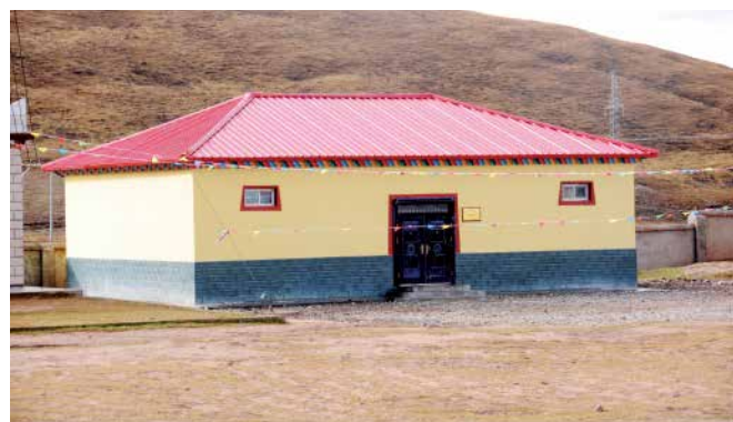
Le nouveau pavillon abrite deux grandes salles séparées pour se doucher et se changer.
