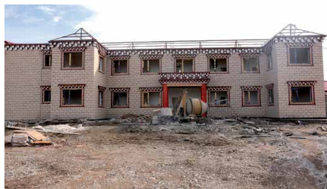
Les deux nouveaux orphelinats en construction: la maison 9 «Sun & Moon House» et la maison 10 «Jaden & Devyen House».
